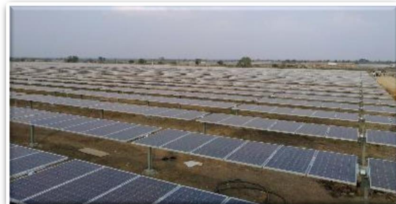
项目地：印度*特伦甘纳邦 规模：172MWp
