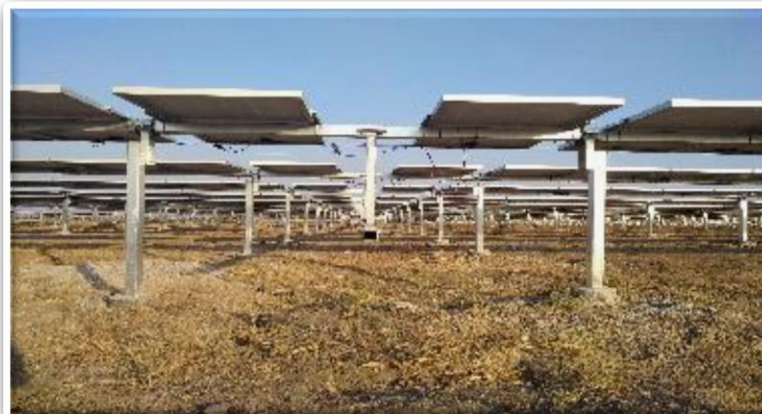
项目地：印度*特伦甘纳邦 规模：78MWp
